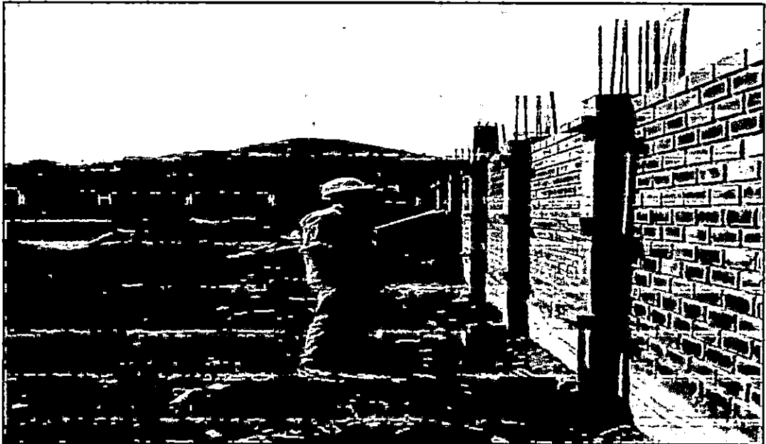
VISTA 06. VISITA DEL SUPERVISOR A OBRA.
